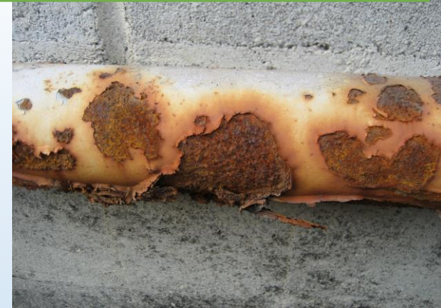
coroziunea sub suprafață
